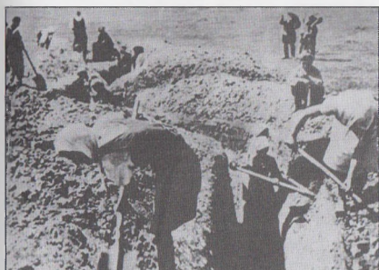
Строительство оборонительных укреплений г. Краснодара. 1942 г.
